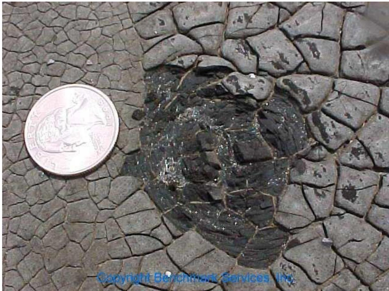
Abbildung 2 - Aufgebautes Dach durch 1 1/2" (3,81cm) Hagel beschädigt
