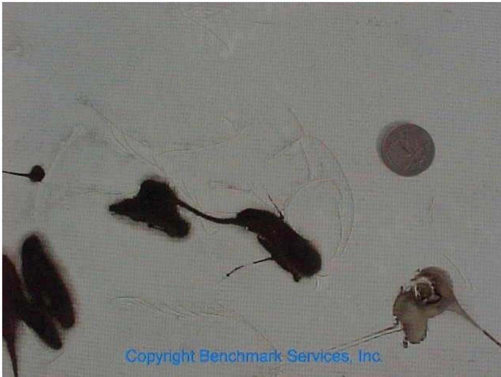
Abbildung 8 - Durch Hagel beschädigte verstärkte PVC-Dachbahn, provisorische Reparaturen mit Dichtungsmasse
