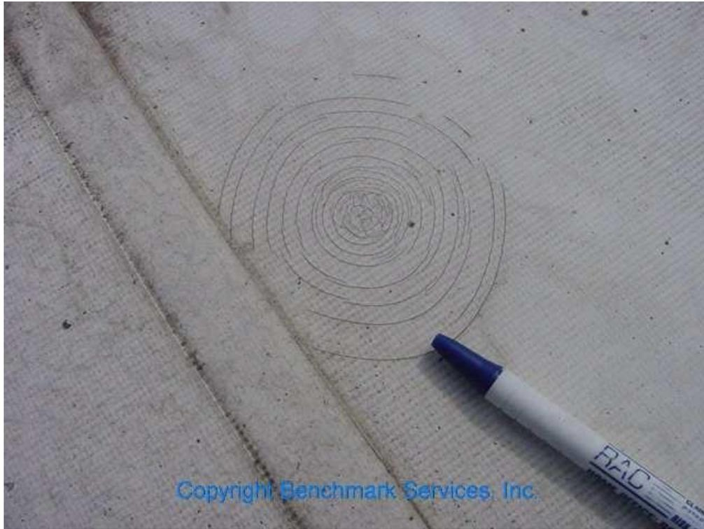
Abbildung 6 - Verstärkte PVC-Dachbahn mit Hagelfrakturen
