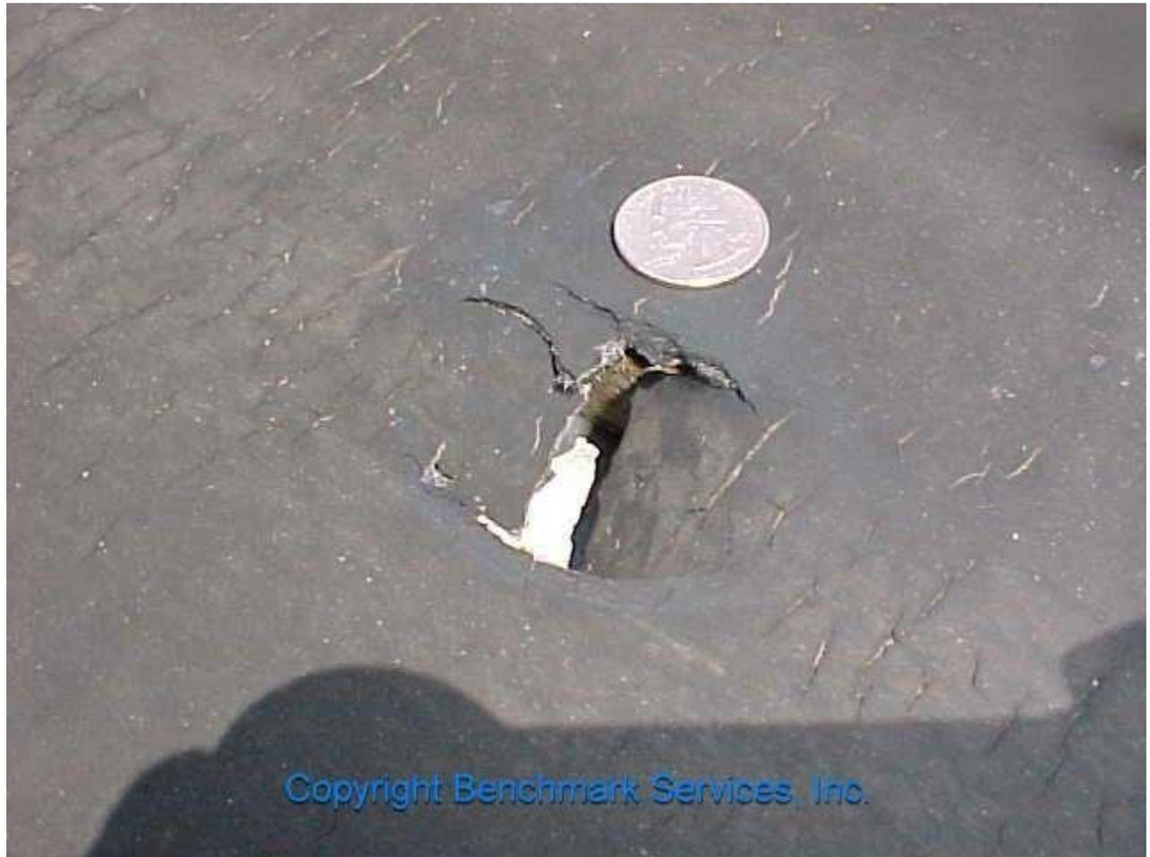
Abbildung 4 - APP-modifiziertes Bitumen von Hagel durchlöchert
