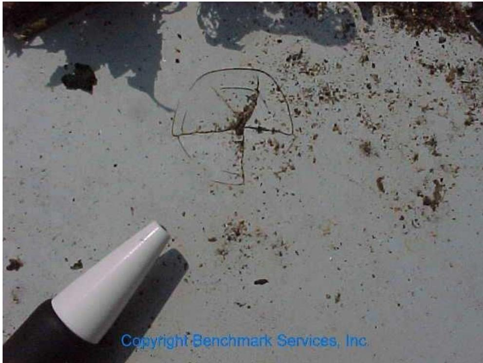
Abbildung 7 - Nicht verstärkte PVC-Dachbahn durch kleinen Hagel beschädigt
