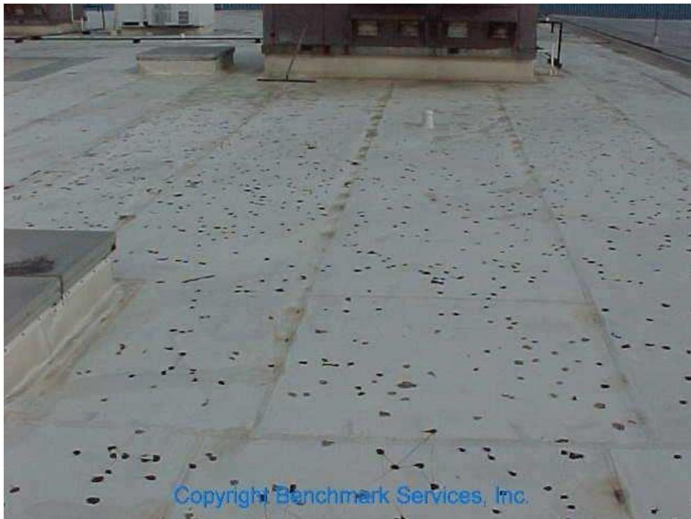
Abbildung 9 - Durch Hagel beschädigte PVC-Dachbahn mit Tausenden von provisorischen Reparaturen mit Dichtungsmasse
