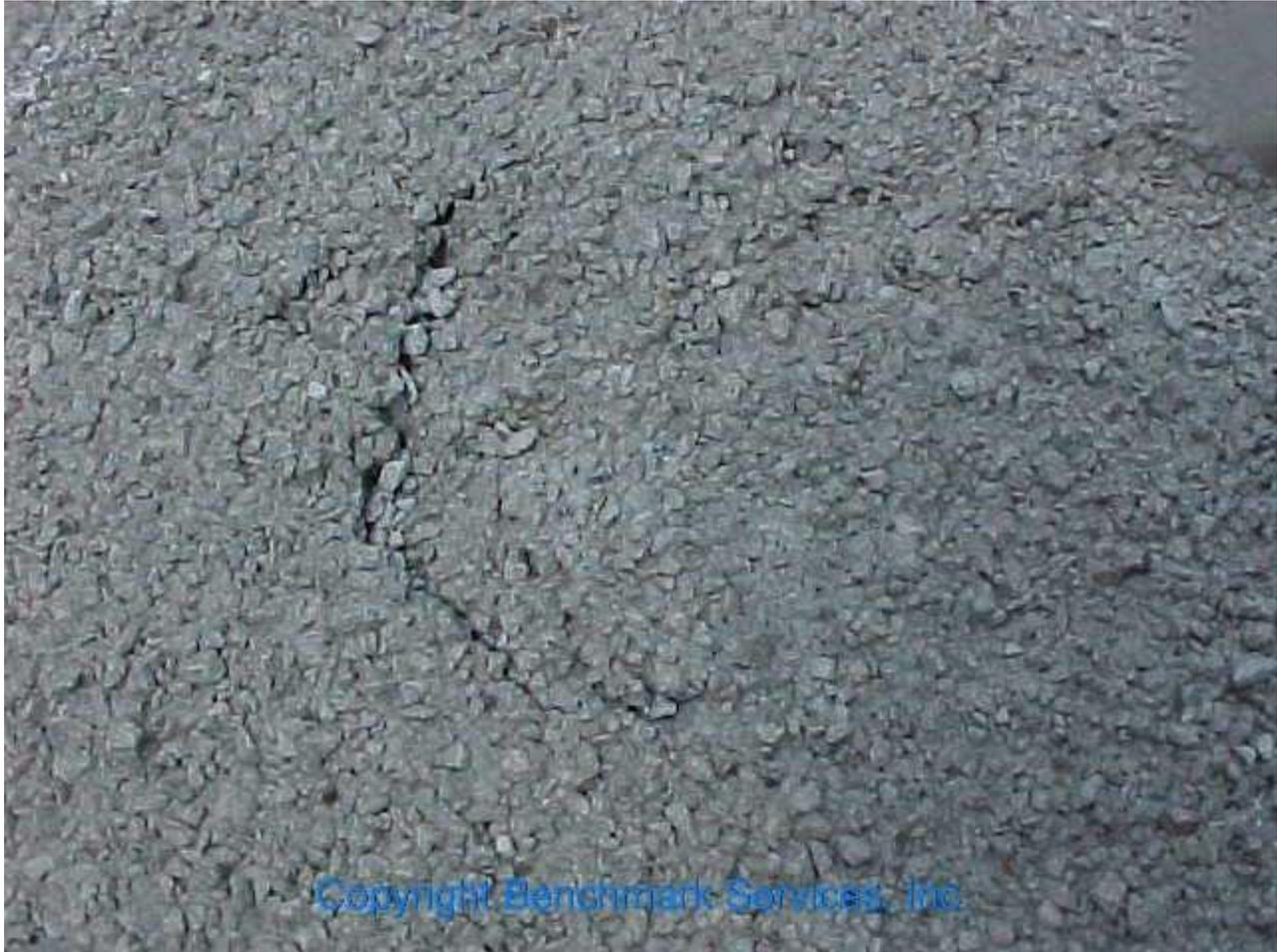
**Abbildung 3 - Hagelgeschädigtes granulatbeschichtetes SPUF-Dach**
