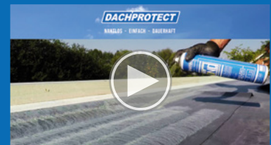
Verklebung mit SprayBond
