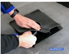
Einsetzen des Gullys
