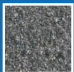
auf ALT- BITUMEN
