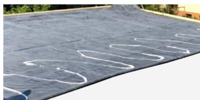
**Tipp:** Die Klebefläche nicht zu groß wählen, um ein Antrocknen des Klebers zu vermeiden. Vom Knick der Dachbahn aus ca. 1,5 m der Fläche mit Kleber versehen und einrollen. Die Größe der einzustreichenden Fläche ist je nach Außentemperatur und Sonneneinstrahlung anzupassen (je wärmer und sonniger, desto kleiner die Fläche).
