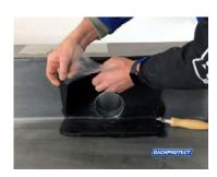
Die Schutzfolie des Flansches vom Garantie-Seitenablauf etwas entfernen, das Rohr in das Loch stecken und den Flansch vorsichtig im Knick andrücken.
