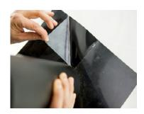
Die Aktivierung auf die EPDM-Oberfläche im zukünftigen Bereich des Flansches (sowie etwas über den Bereich) mithilfe eines oberflächenaufrauenden Schwammes auftragen und fingertrocken ablüften lassen.
