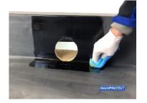
Nach dem Verkleben der Dachbahn im Kontaktklebeverfahren das Loch einschneiden und den zu aktivierenden Bereich mit einem trockenen Tuch reinigen.
