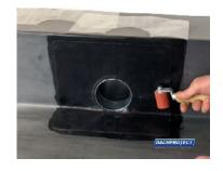
Abschließend den Knick mit einem Metall-Eckenroller und die Fläche mit einer Silicon-Andrückrolle kräftig anrollen.
